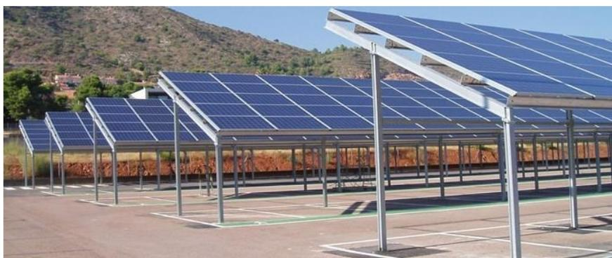
Figura 25. Modelo de estructura soporte. Fuente: Autosolar
